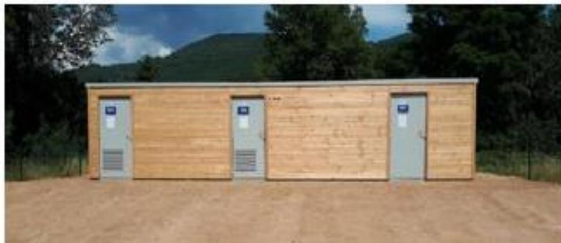
Figure 6 : Exemples de postes onduleur-transformateur
